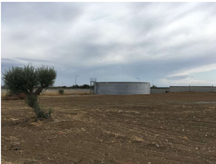
Figura 3.22 – Depósito de efluente existente a integrar na nova ETAR.
