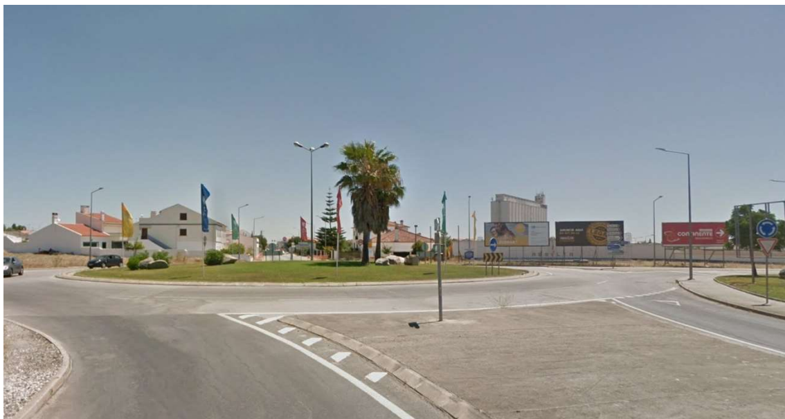
Figura 4.10.3 – Entrada em Reguengos de Monsaraz, no acesso à Zona Industrial.
